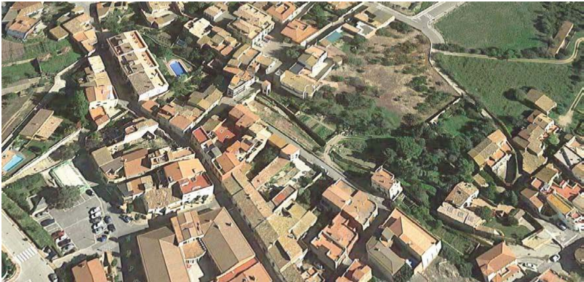
Imatge de l'àmbit amb Can Lluent enderrocat i les obres de l'equipament pendents d'executar
